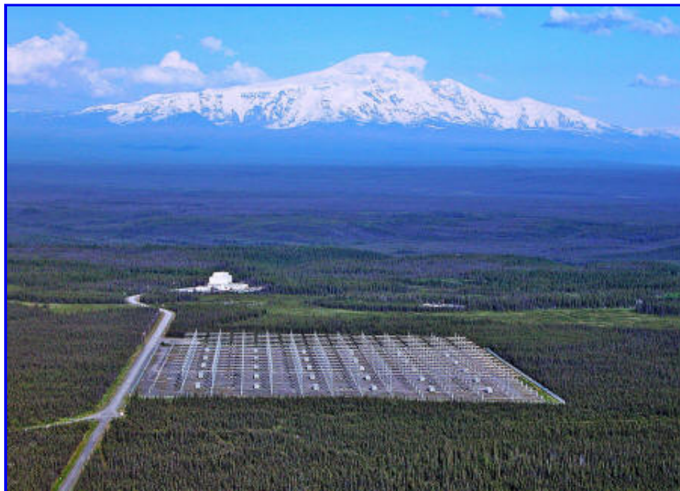
Esta infraestructura que abarca 14 kilómetros cuadrados en Gakona, al sureste de Fairbanks, Alaska, constituye el arsenal climatológico del Pentágono.
