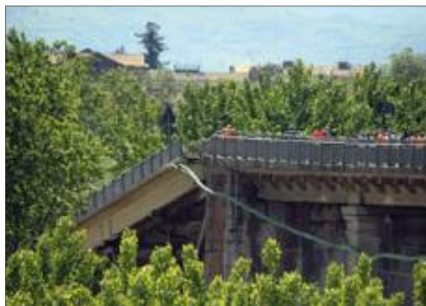
Ponte crollato a Piacenza il 30 aprile.
