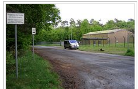
Tanklager der FBG bei Altenrath
