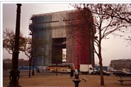
L'Arc de Triomphe et son échafaudage pendant la campagne de restauration de 1988.
