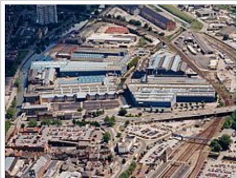
Siemens Pelham Works
